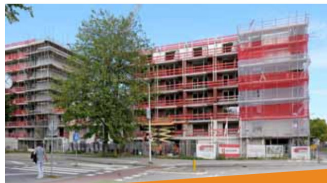
Nieuwbouw van Stadgenoot aan de IJdoornlaan, hoek Volendammerweg
